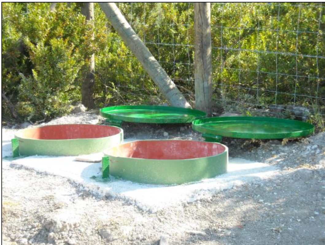
Figura 6.- Pozos para la instalación del sensor de banda y del acelerómetro en la estación PRO2.
