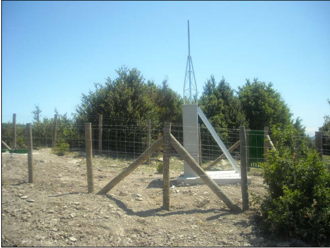
Figura 4.- Obra civil de la estación sísmica PRO2: torre de comunicaciones, armario de la instrumentación y pozos para los sensores.
