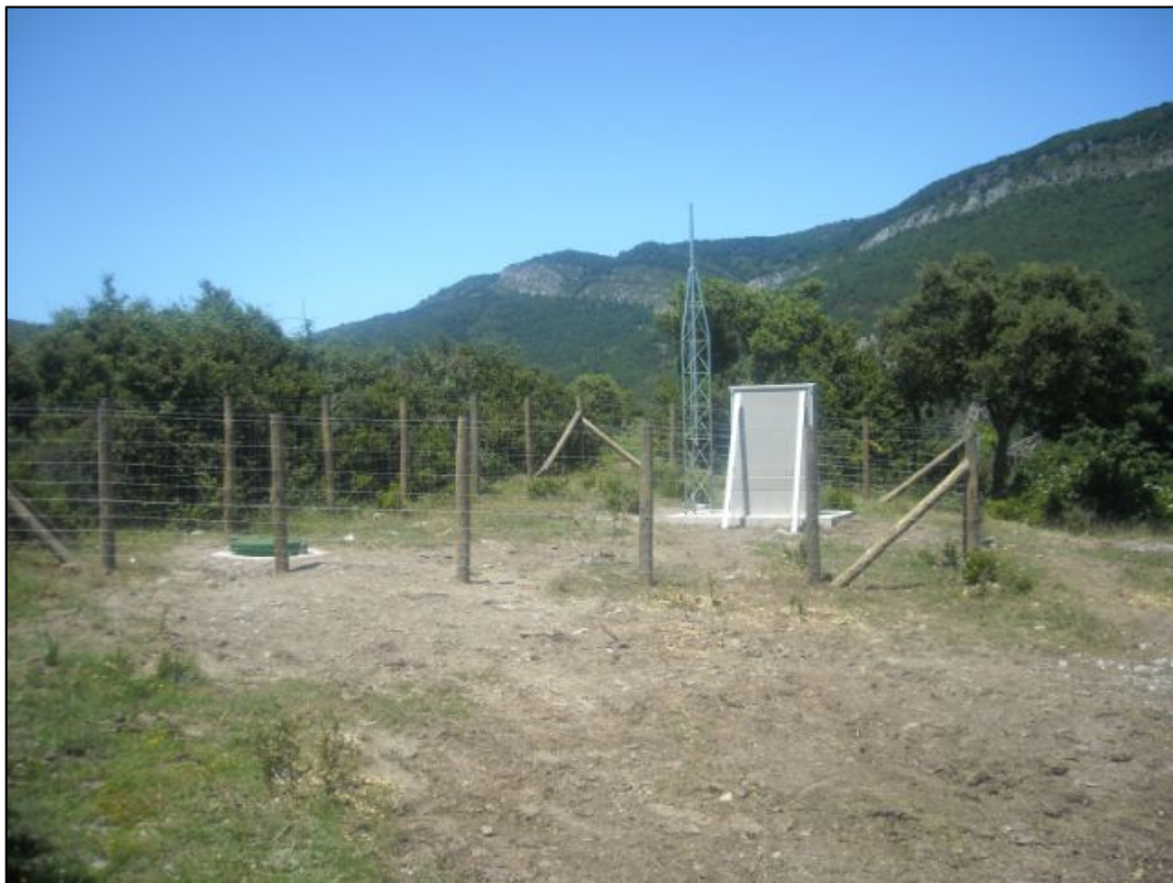
Figura 3.- Obra civil de la estación sísmica PRO1: torre de comunicaciones, armario de la instrumentación y pozo para el sensor.
