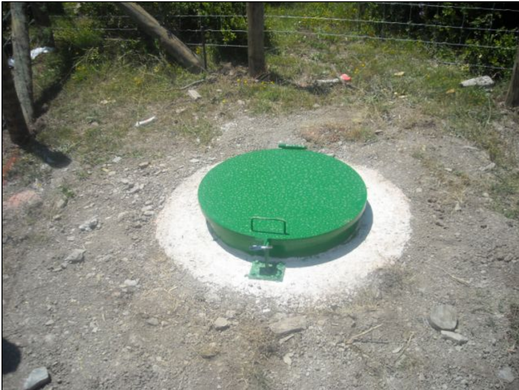
Figura 5.- Pozo para la instalación del sensor de corto periodo en la estación PRO1.
